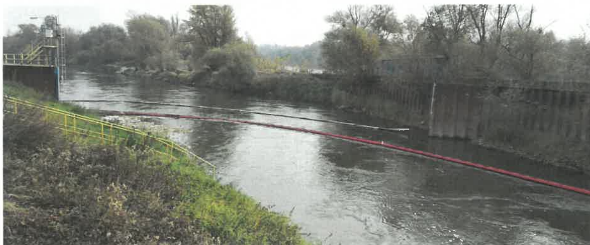
Zdj. 1. Widok zapory olejowej – do częściowej wymiany.
